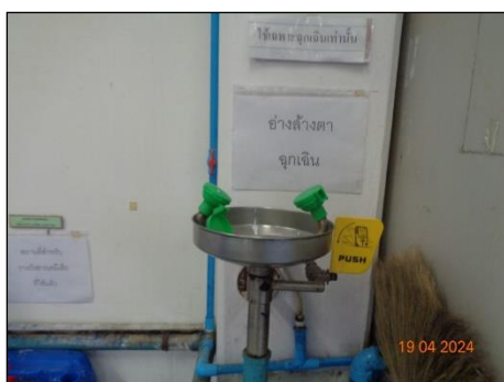
ภาพที่ 2.2-26 ฝักบัวฉุกเฉินและที่ล้างตา
