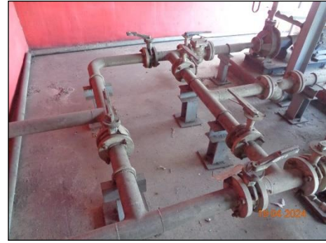
ภาพที่ 2.2-34 วาล์วปิด-เปิด ท่อสารเคมี ที่อยู่นอกคั่นกันสารเคมี
