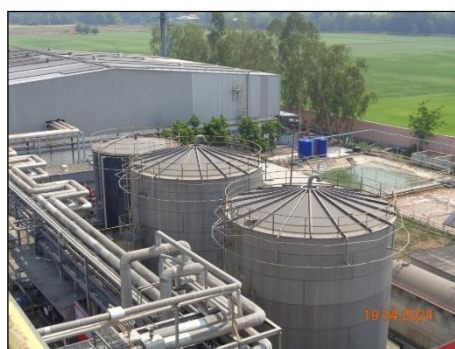
ภาพที่ 2.2-31 ระบบสเปรย์น้ำรอบถังเก็บ EG
